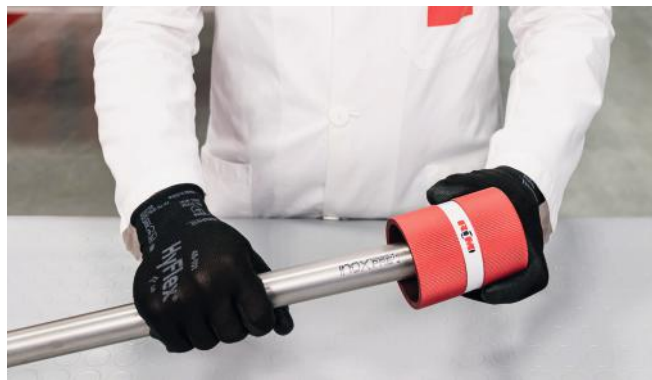
Bild 21 – Entgraten des Leitungsrohres
