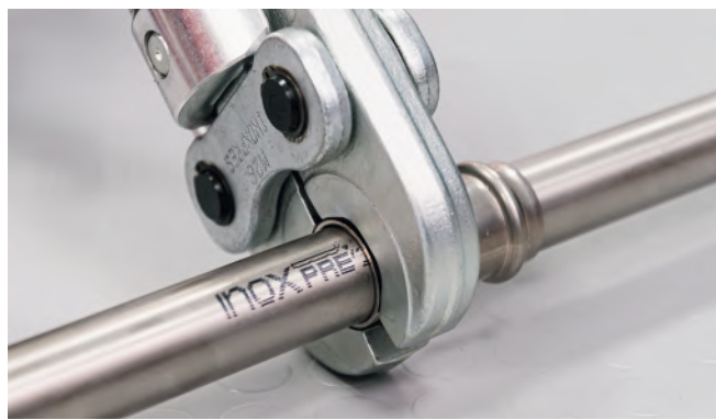
Bild 26 – Herstellen der Pressverbindung
