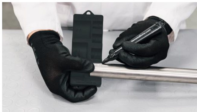
Bild 23 – Markieren der Einstecktiefe
