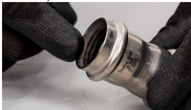
24. Ábra – A tömítőgyűrű ellenőrzése
