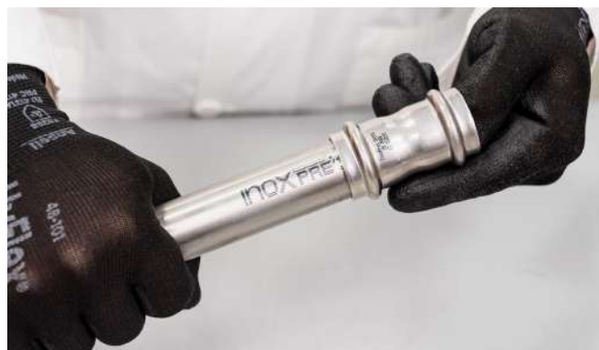
25. Ábra – Cső behelyezése a présidomba
