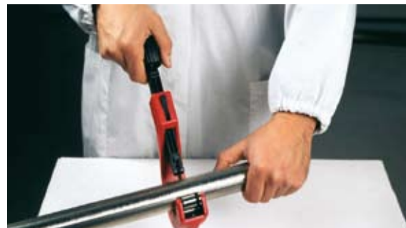
Bild 15 - Ablängen des Leitungsrohres
