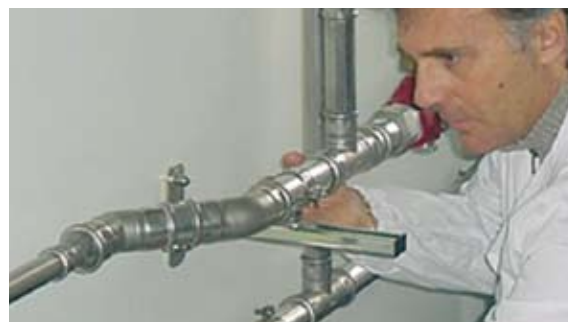
Imaginea 23 - Verificarea racordării de presare
