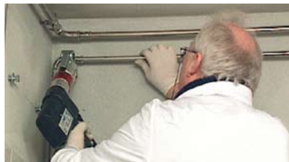
Imaginea 22 - Realizarea racordării de presare
