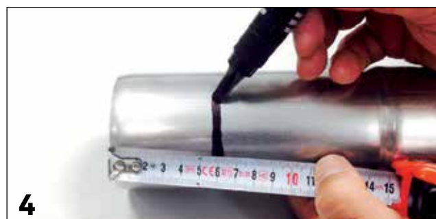
4 Marcatura quota d'innesto / Marking the insertion's depth
