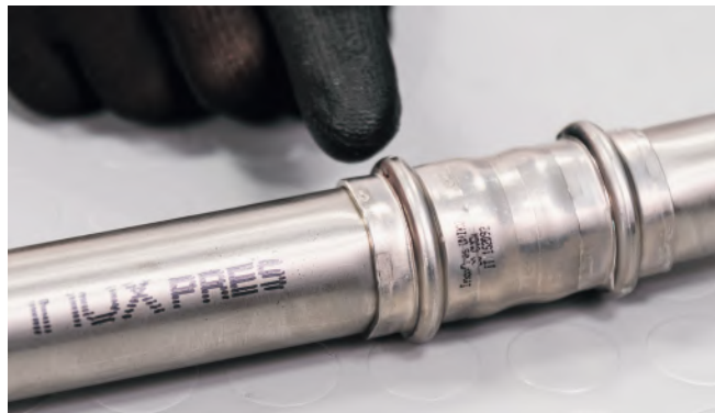
Figura 27 - Controllo della pressatura
