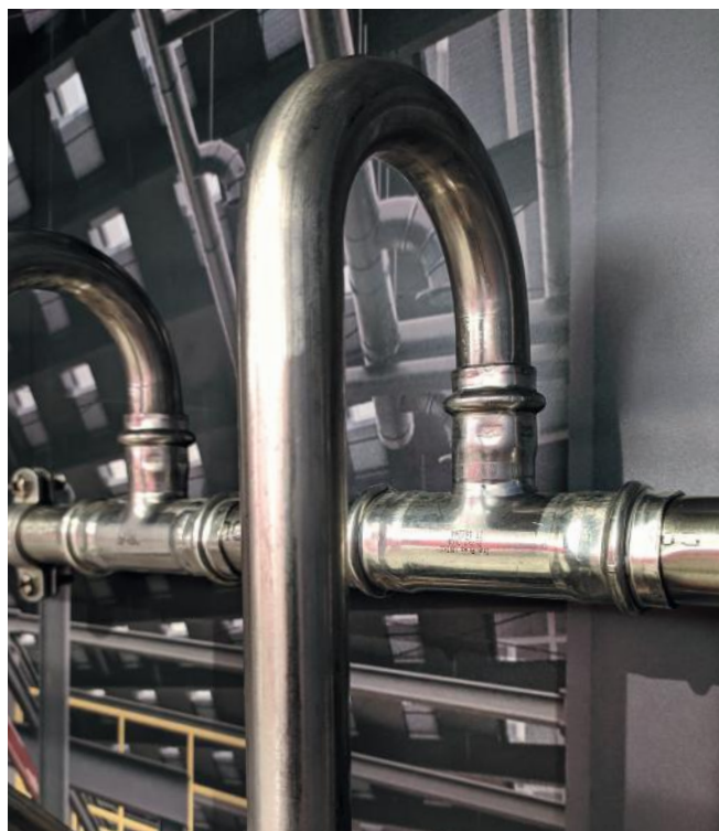
Figura 18 - inoxPRES UNIKO - Aria compressa
