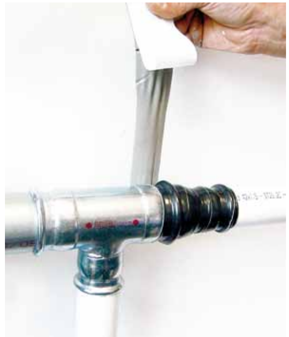
Obr. 25 - Ochrana prípojok butanолоvou lepiacou páskou.
