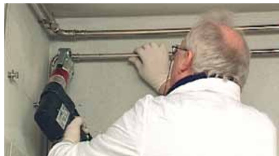
Obrázok 22 - Vytvorenie lisovaného spoja
