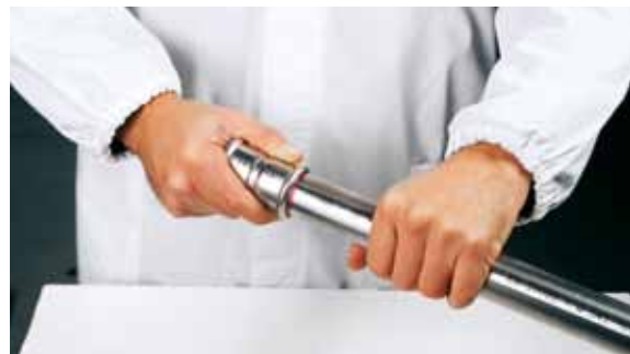
Obrázok 21 - Zavedenie rúry do lisovanej spojovacej tvarovky
