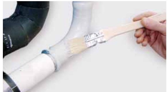
Obr. 24 - Lakovanie prípojok a rúr so základným náterom.
