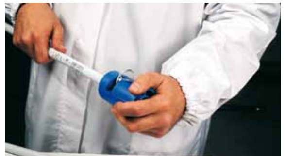
Obrázok 19 - Odpláštenie (Steelpres)
