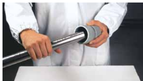
Obrázok 16 - Zbavenie potrubnej rúry výronkov
