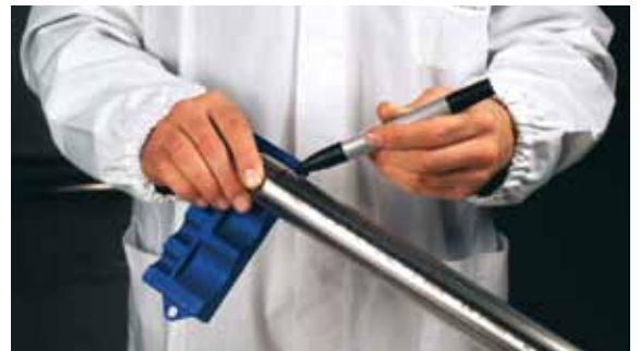
Obrázok 18 - Označenie hĺbky zasunutia
