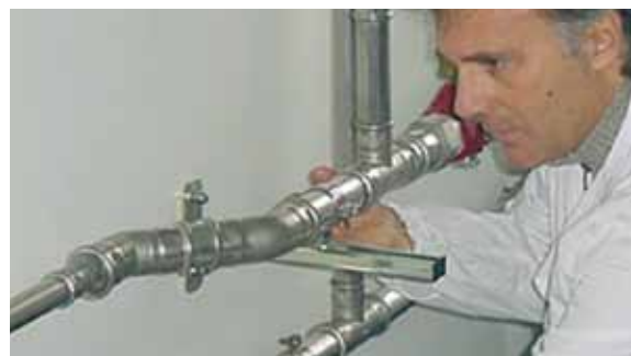
Obrázok 23 - Kontrola lisovaného spoja
