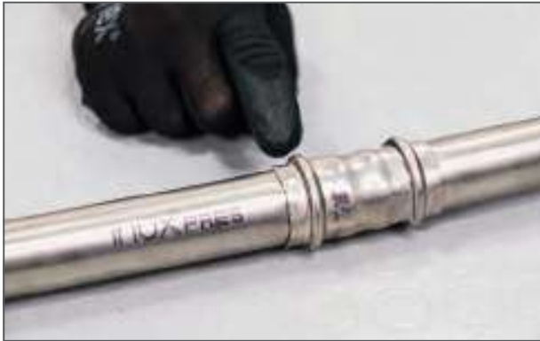
Controllo della pressatura / Checking the press connection
