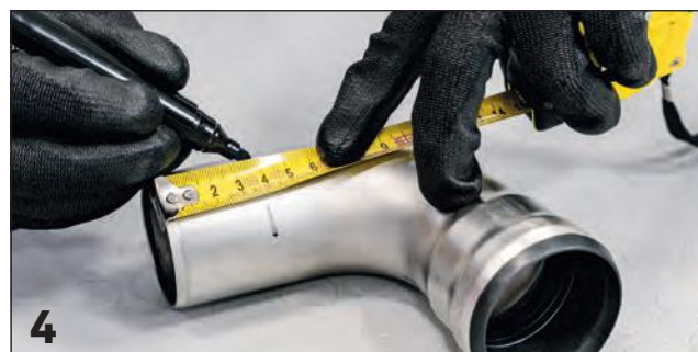
Marcatura quota d'innesto / Marking the insertion's depth
