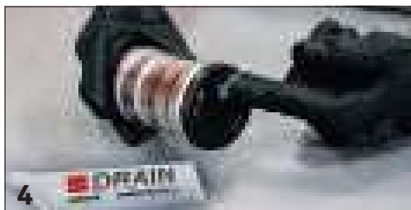
4 Lubrificazione zona interna guarnizione / Internal gasket lubrication
