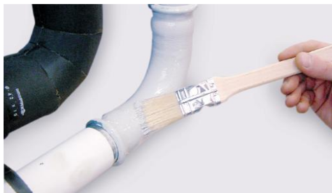
37. ábra – A csatlakozás és a cső festése alapozás után
