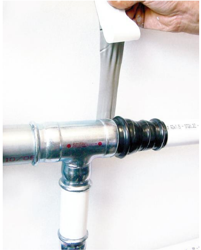
38.ábra – Kötésvédelem butanol ragasztószalaggal
