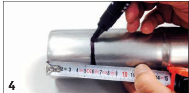
4 Marcatura quota d'innesto / Marking the insertion's depth
