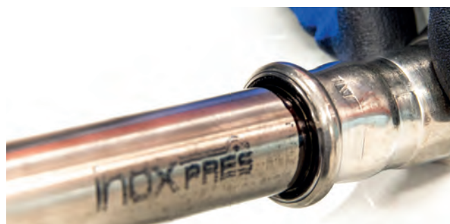
33. attēls - Nepareizas atzīmēšanas piemērs
