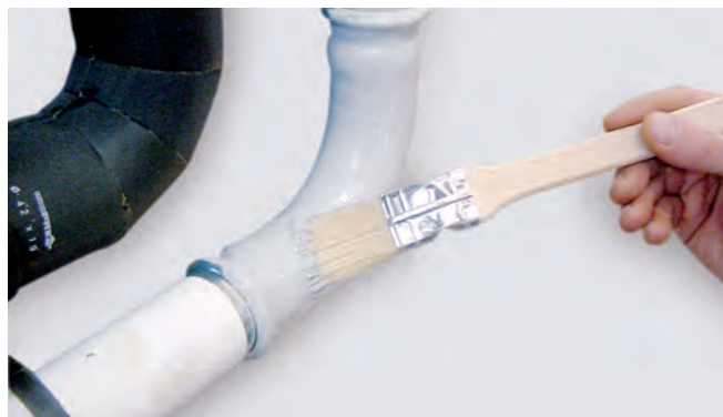
42. attēls – Savienojumu un cauruļu gruntēšana
