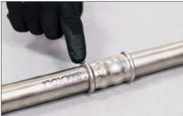
Controllo della pressatura / Checking the press connection
