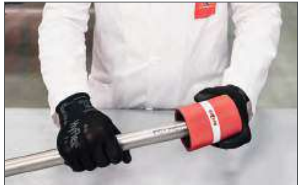
Sbavatura del tubo / Deburring the pipe
