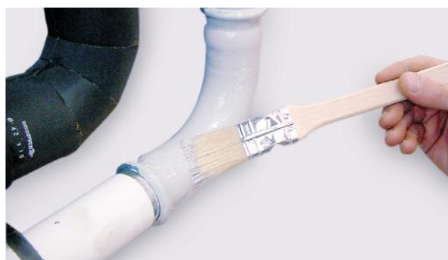
Figura 38 - Verniciatura raccordi e tubazioni con primer
