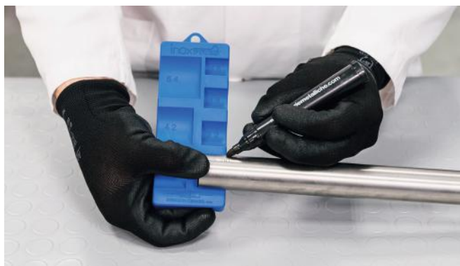
Figura 29 – Marcatura della profondità d'innesto
