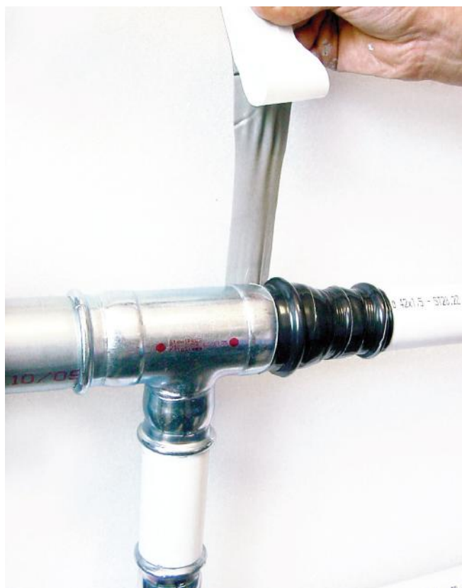
Figura 39 – Protezione dei raccordi con nastro isobutilico
