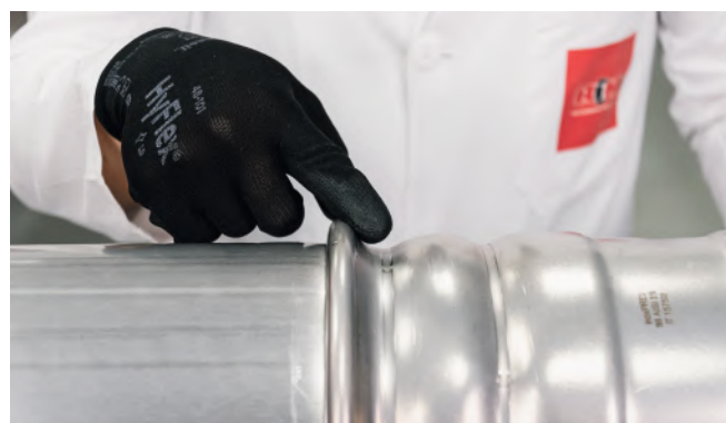
Figura 37 - Controllo visivo pressatura Oversize
