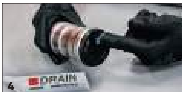
Lubrificazione zona interna guarnizione / Internal gasket lubrication
