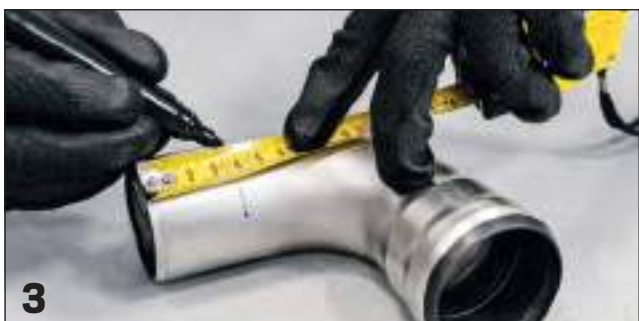
Marcatura quota d'innesto / Marking the insertion's depth
