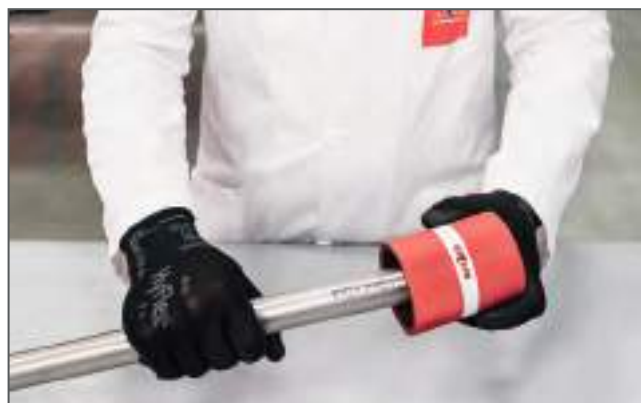
Sbavatura del tubo / Deburring the pipe
