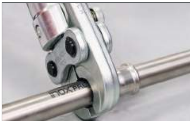
Assemblaggio attraverso pressatura / Making the press connection
