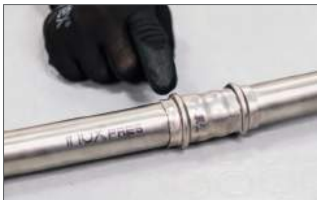
Controllo della pressatura / Checking the press connection
