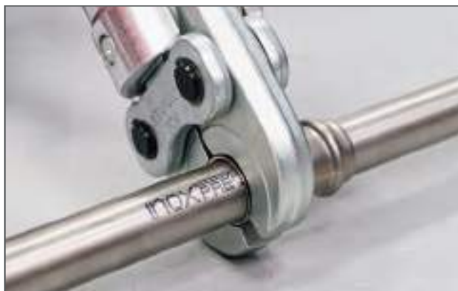
Assemblaggio attraverso pressatura / Making the press connection
