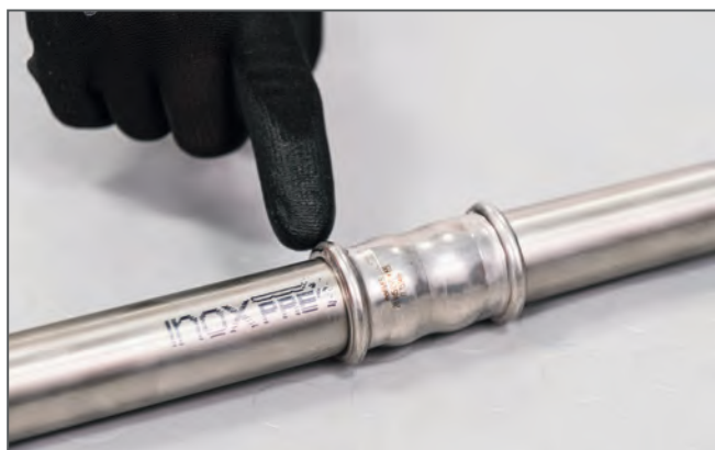
Controllo della pressatura / Checking the press connection
