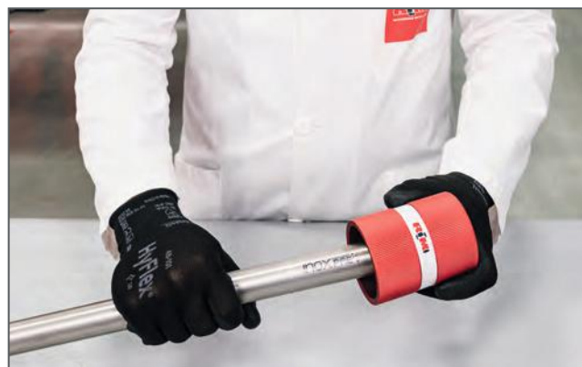
Sbavatura del tubo / Deburring the pipe
