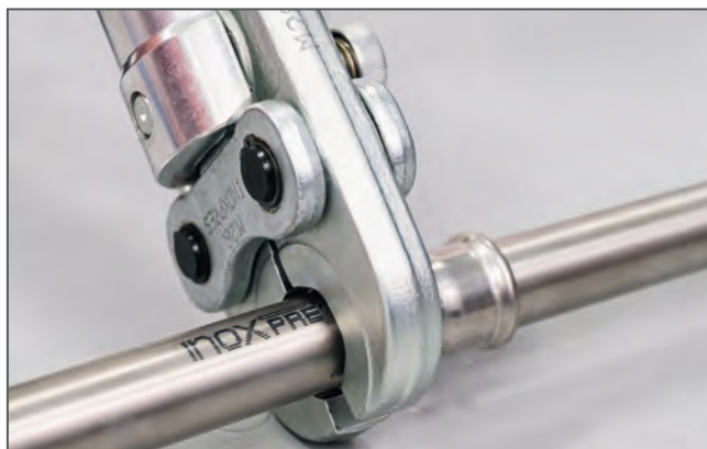
Assemblaggio attraverso pressatura / Making the press connection
