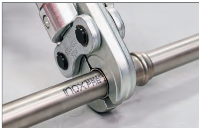
Assemblaggio attraverso pressatura / Making the press connection
