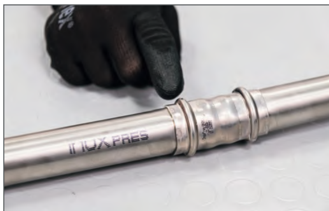
Controllo della pressatura / Checking the press connection
