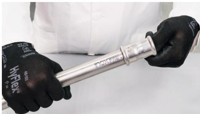
Image 31 – Introduction du tube dans le raccord
