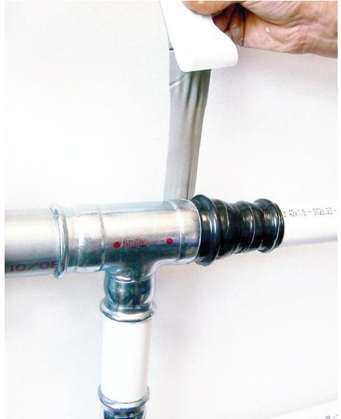
**Image 38** - Protection des raccordement avec la bande adhésive
